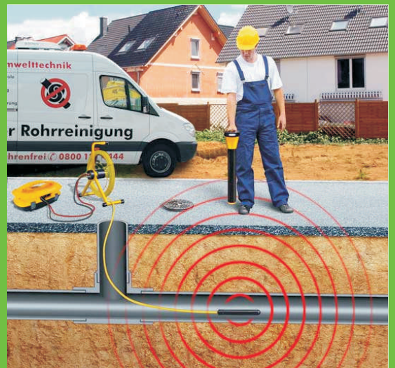
Punktueller Kanalortung hat nichts mit Wünschelrutengängen zu tun, sondern mit präzisen Ortungstechnologien.
